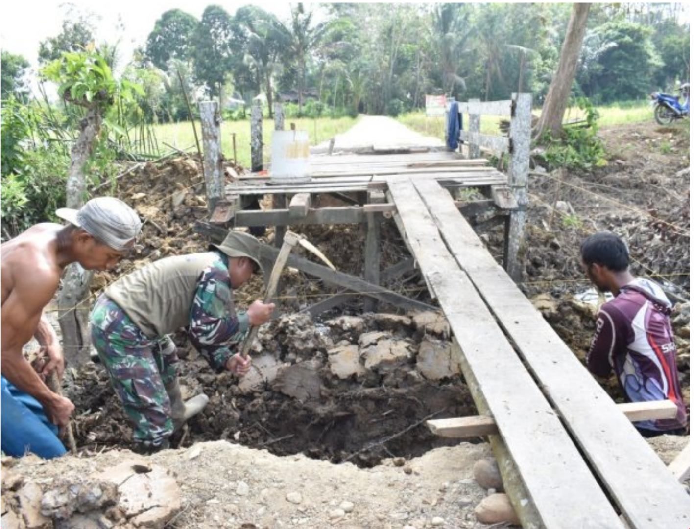
Abutment Jembatan Dikerjakan Satgas TMMD Ke-116 Kodim 1002/HST
