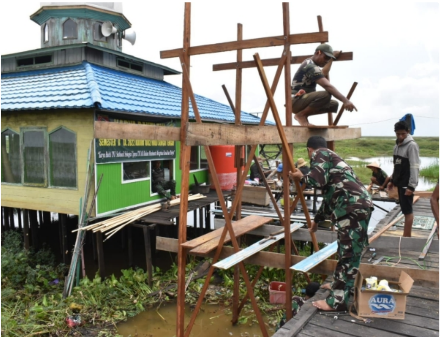
Anggota Kodim 1002/HST Sedang Membangun Tempat Penampungan Air Bersih Di Dusun Awang Landas
