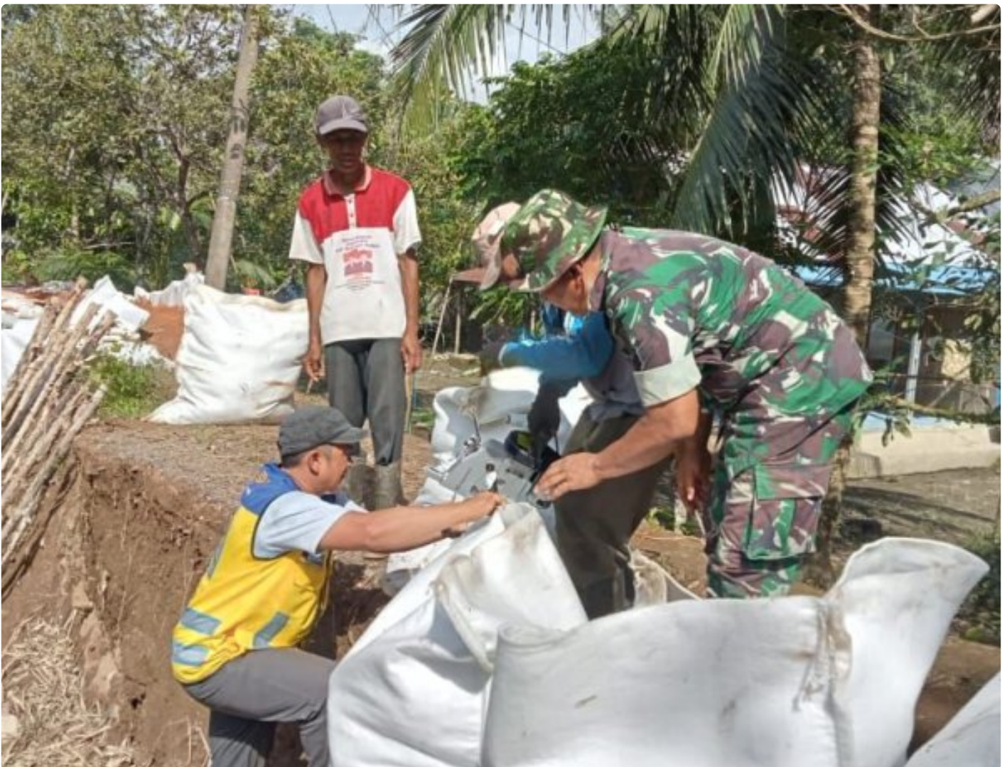
Babinsa Koramil 1002-02/Batang Alai Utara Turun Langsung Gotong Royong Perbaiki Tanggul
