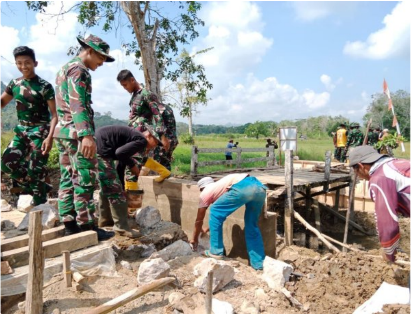
Capai 30 persen, Pengerjaan Rebah Jembatan Terus Digenjot
