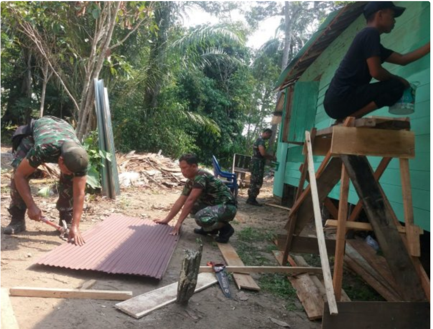
Gerak Cepat, Kodim 1002/HST Rehab Rumah M. Yusuf Capai 80 Persen
