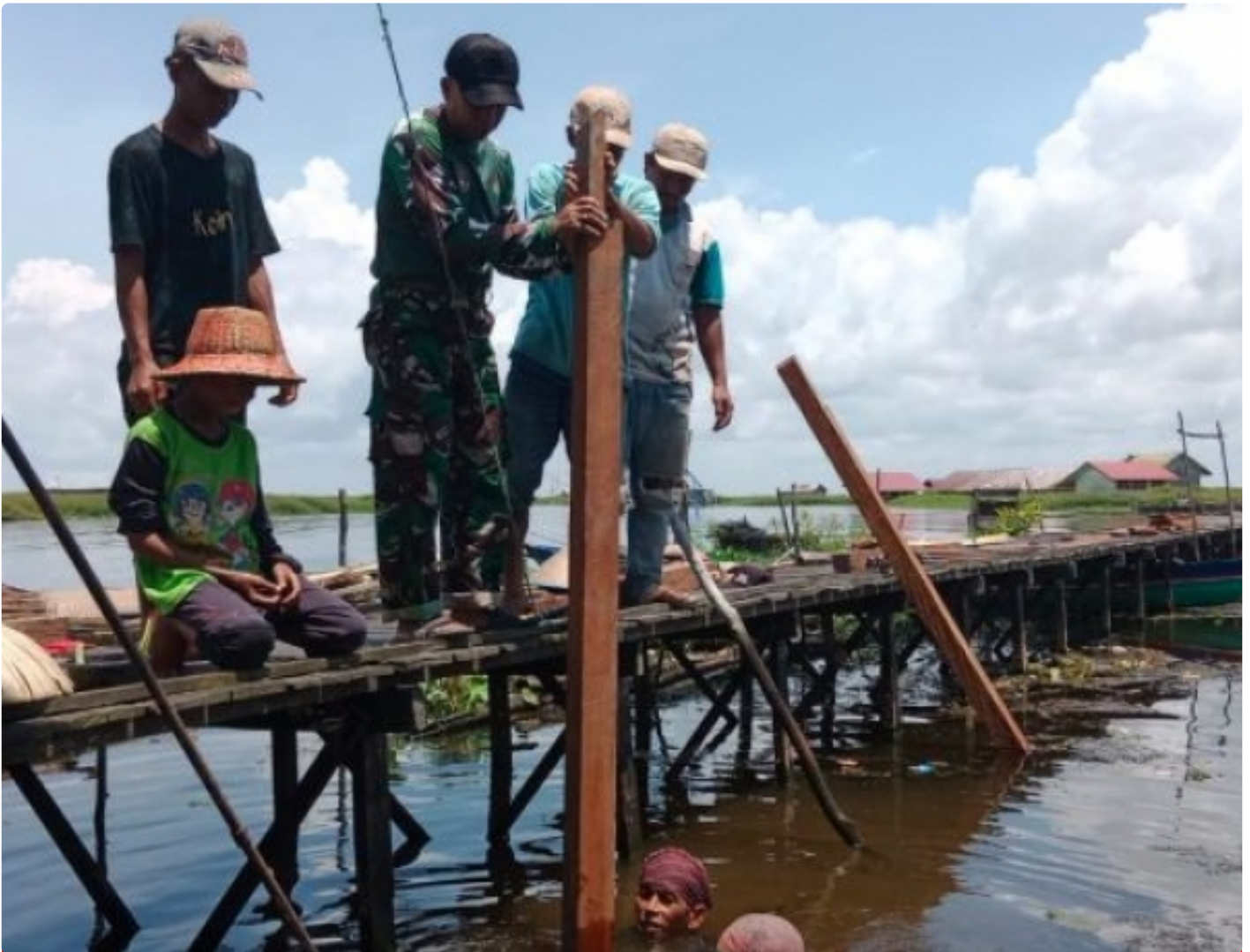
Pemasangan Tiang Penampungan Air
