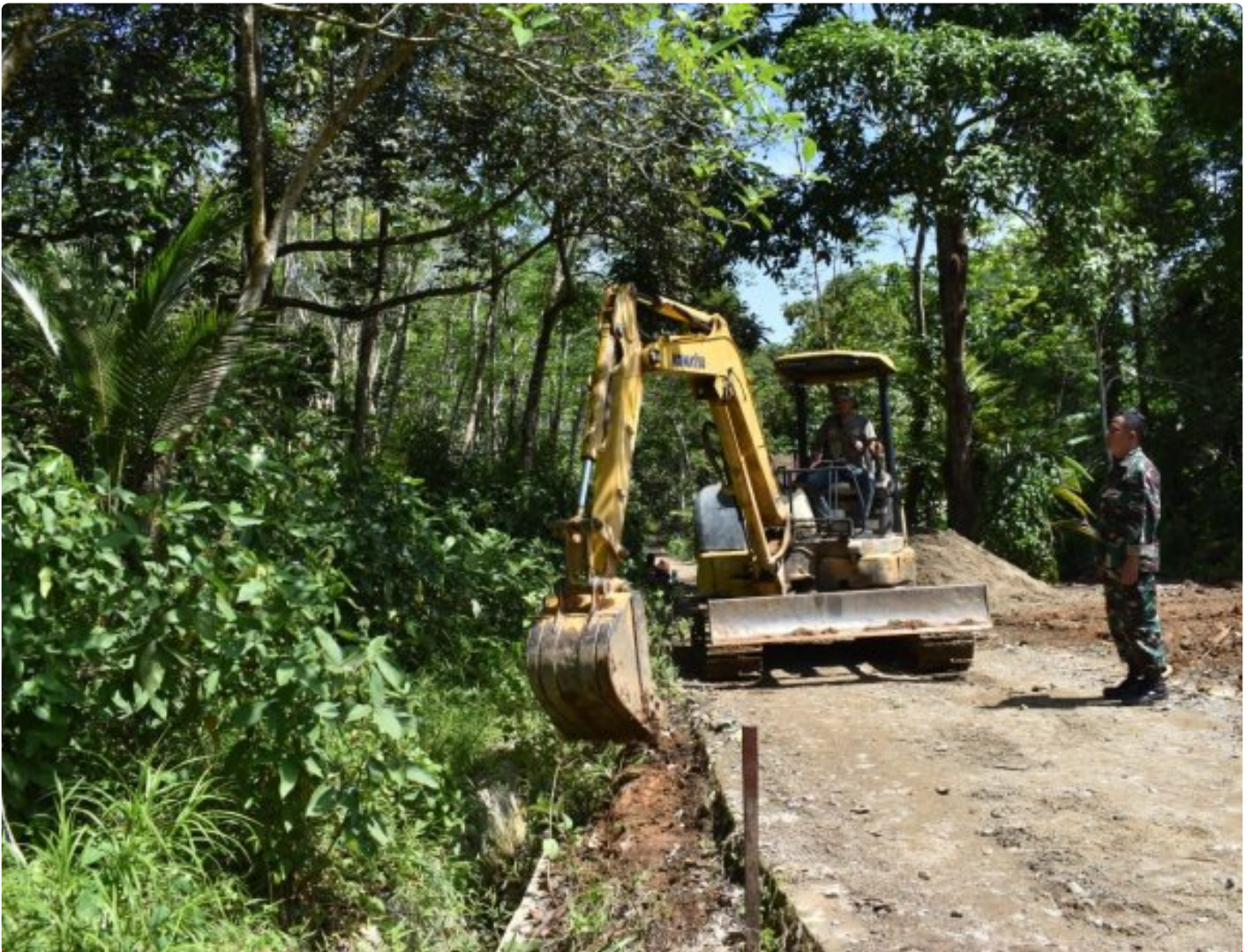
Jalan Sasaran TMMD ke-116 Kodim 1002/HST Dibantu ALat Berat Buka Jalan
