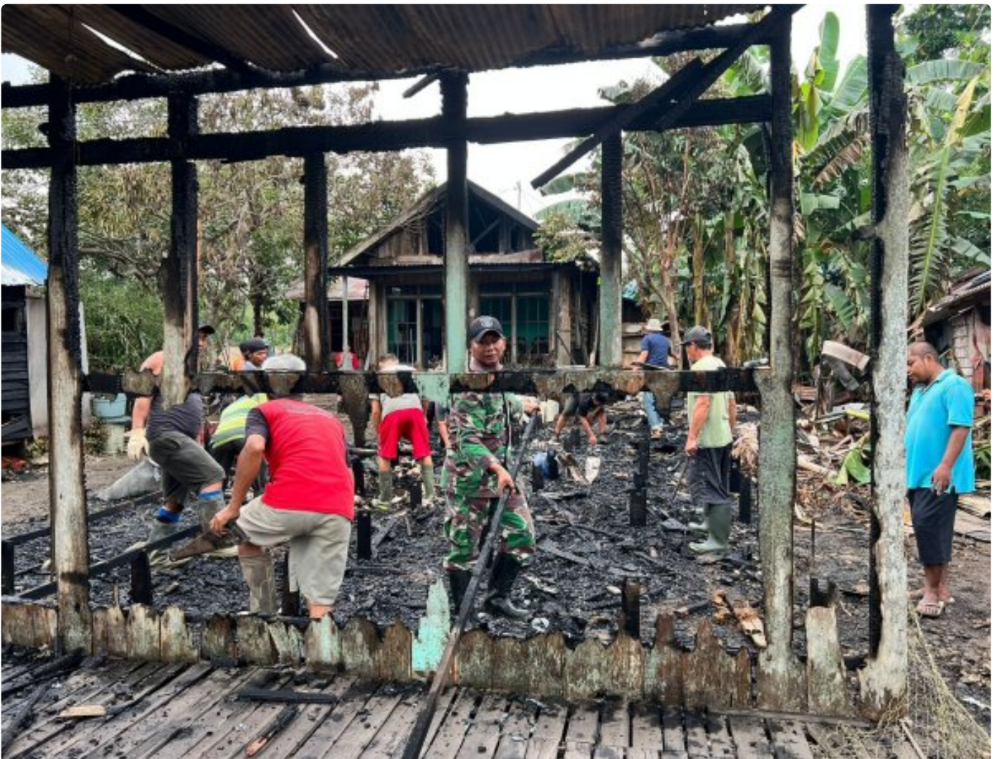
Koramil 1002-06/Barabai Pembersihan Puing Sisa Kebakaran Rumah Warga
