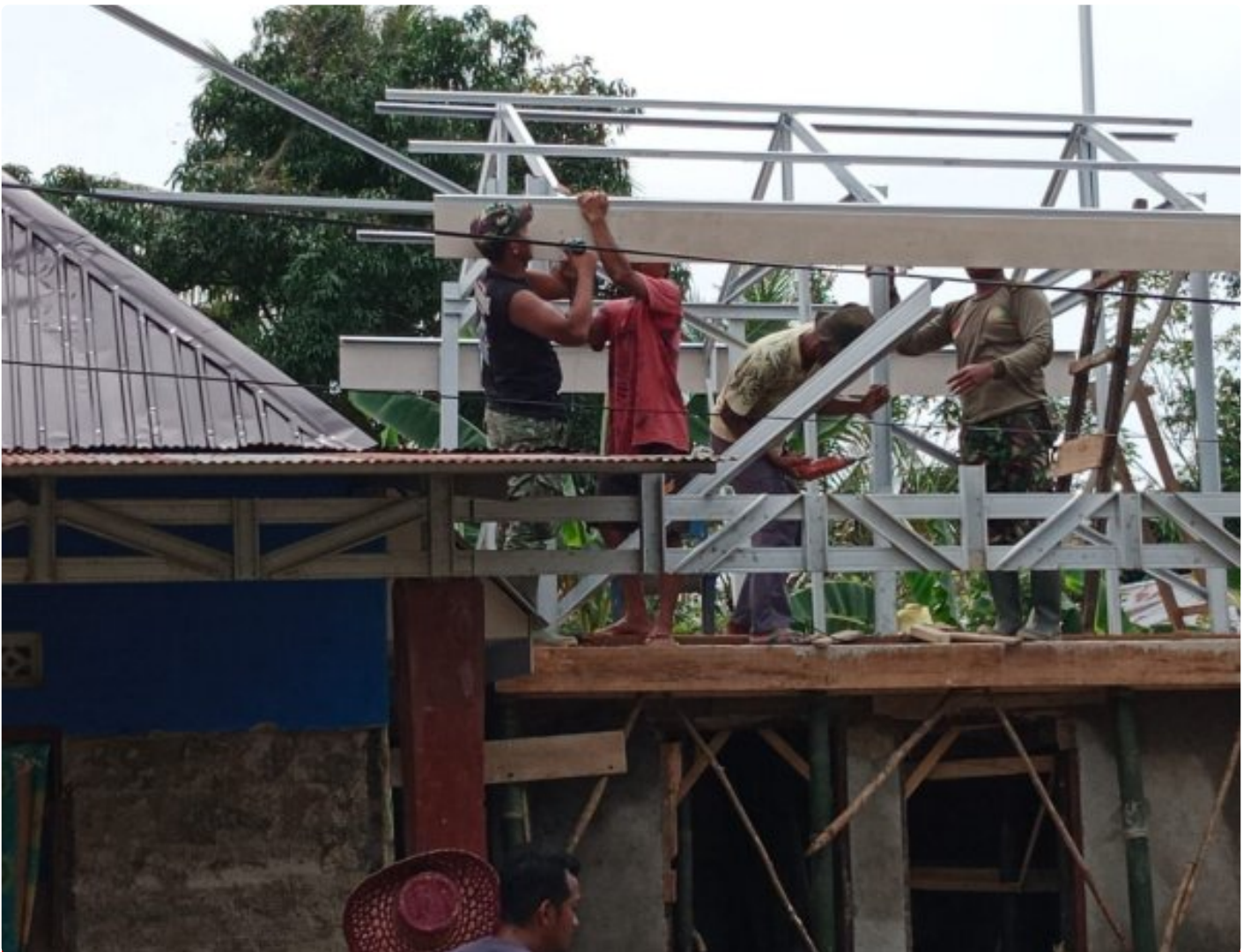
Pemasangan Rangka Atap Teras dan Mushola Darul Iman
