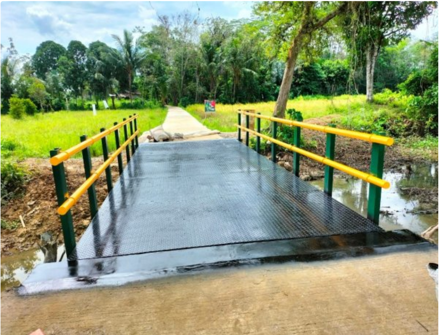
Pembangunan Jembatan Besi Ramping Seratus Persen
