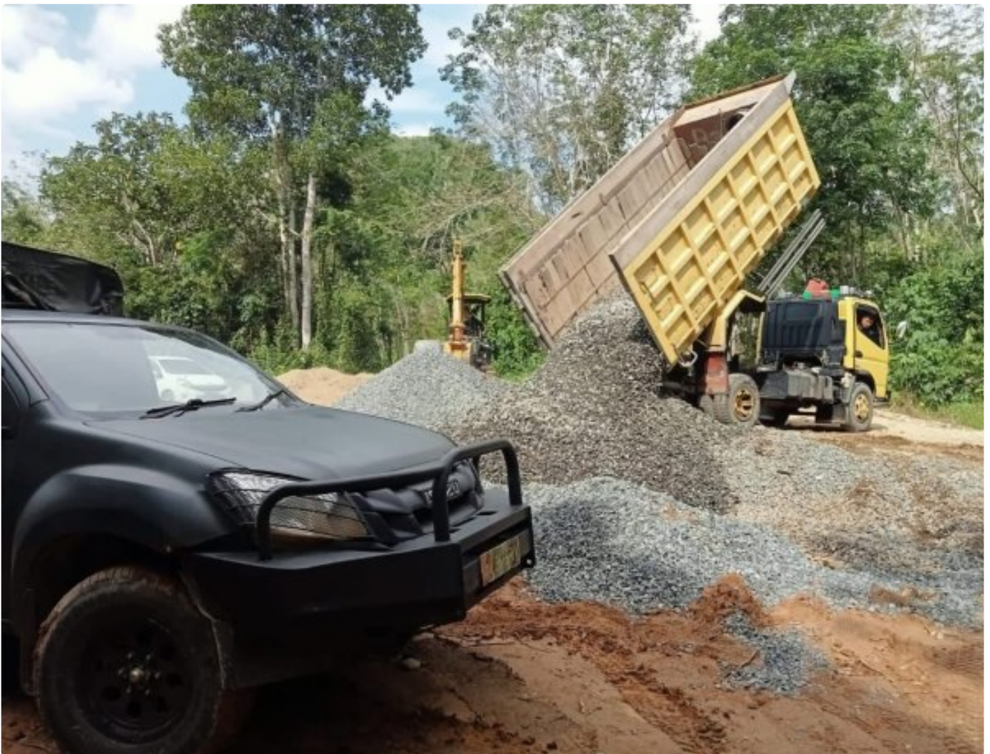
Pra TMMD ke-116 Tahun 2023 Kodim 1002/HST, Material Terus Didatangkan Ke Lokasi
