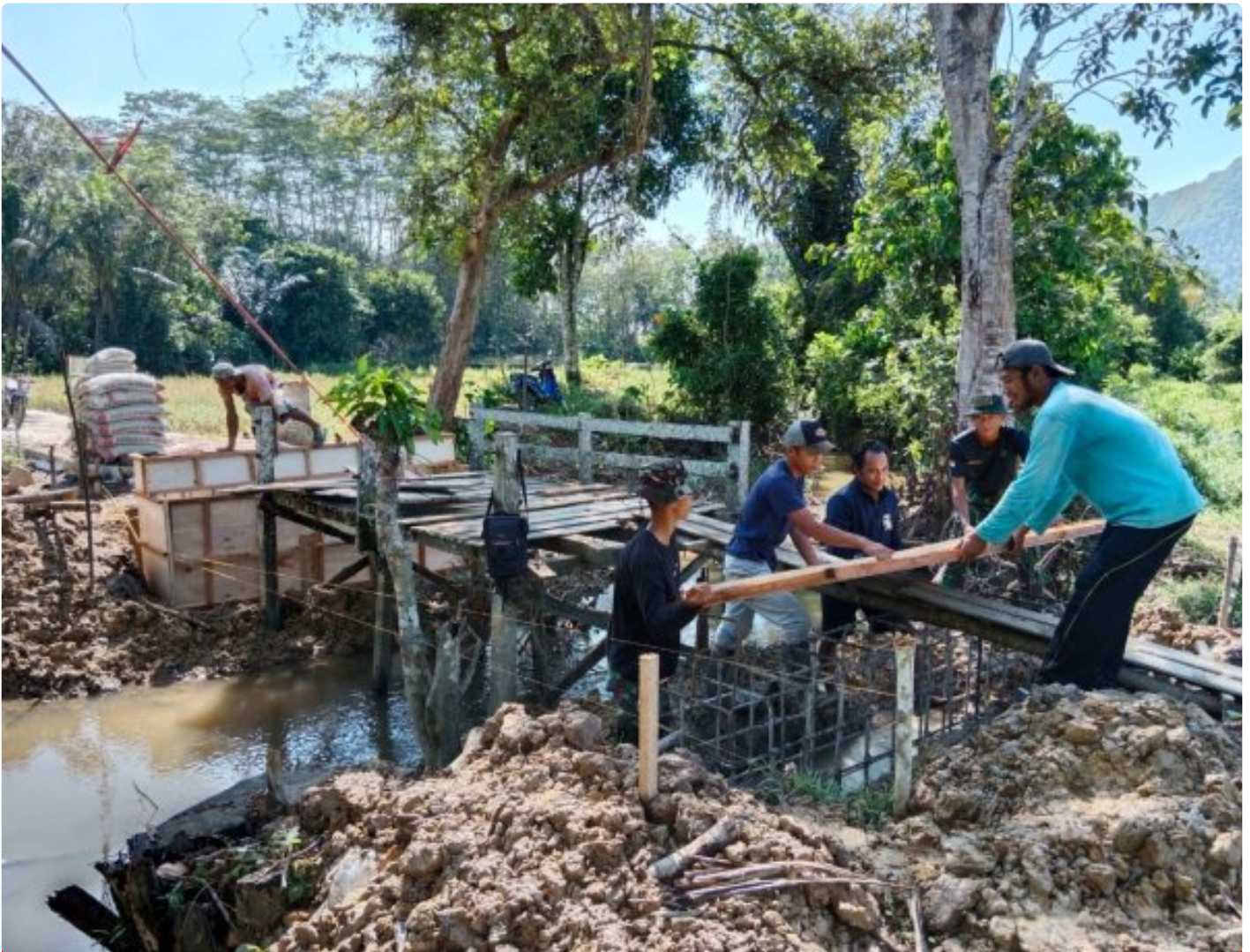
Progres Pengerjaan Jembatan, Satgas TMMMD Cor Abutment
