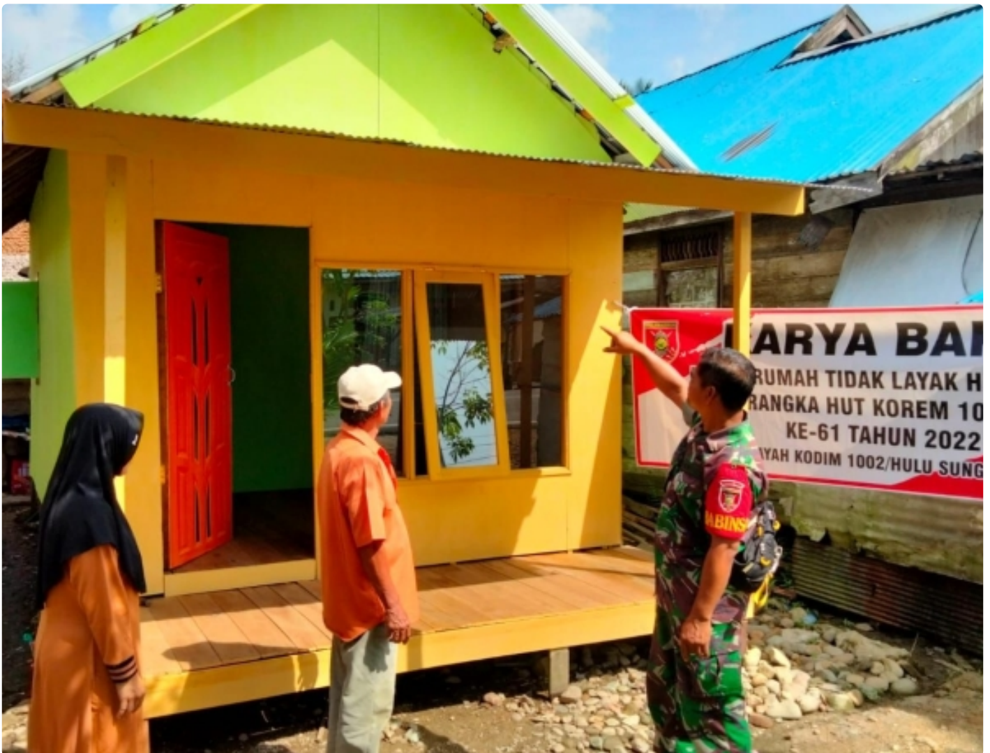
Rampung 100 Persen, 2 Unit Bedah RTLH Kodim 1002/HST Siap Diserahkan
