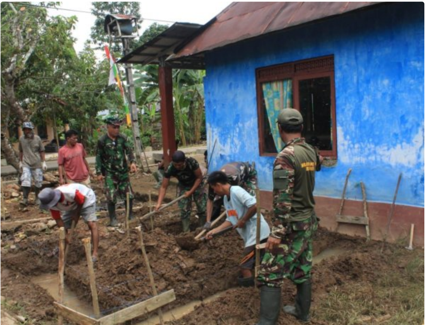
Rehab Musholla Darul Hair Mulai Dikerjakan Oleh Satgas TMMMD ke-116 Kodim 1002/HST
