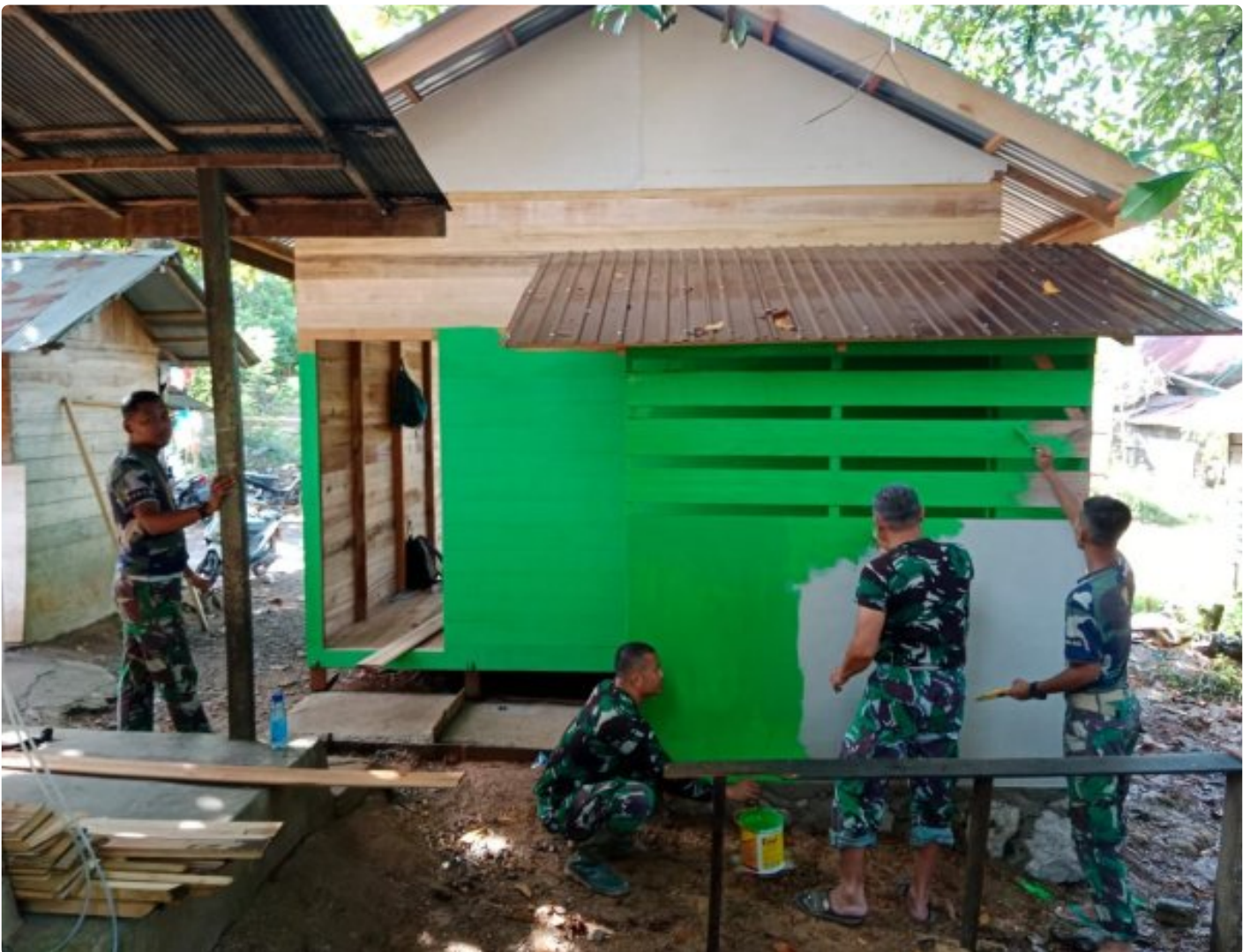
Rehab RTLH TMMMD ke-116 Kodim 1002/HST Masuk Tahap Pengecetan
