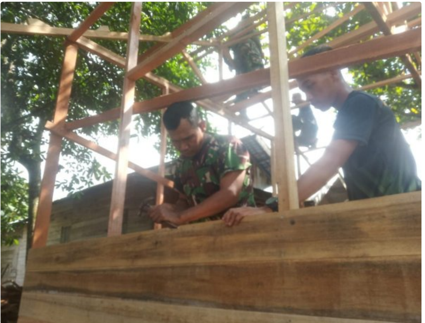
Rehab Tidak Layak Huni TMMMD Ke-116 Kodim HST Pasang Dinding Dan Lantai Rumah
