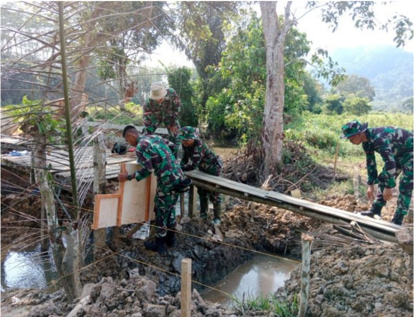
Satgas TMMMD ke-116 Kodim 1002/HST Dikerjakan Jembatan
