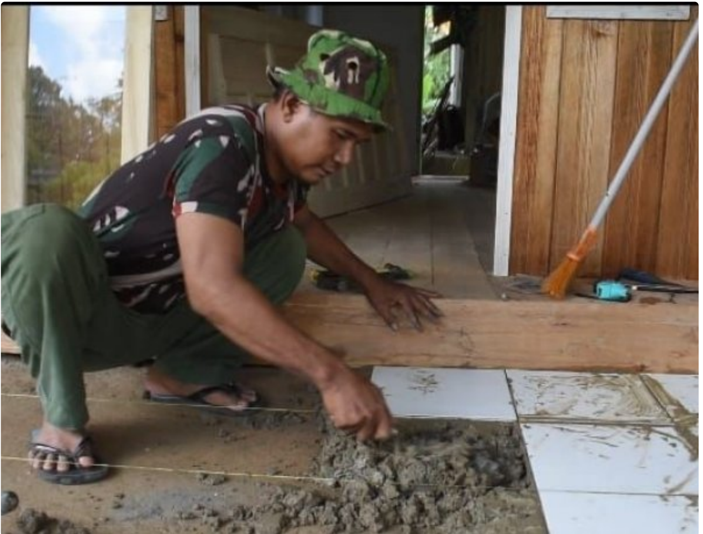
Satgas TMMMD ke-116 Kodim 1002/HST Lakukan Pemasangan Keramik di RTLH
