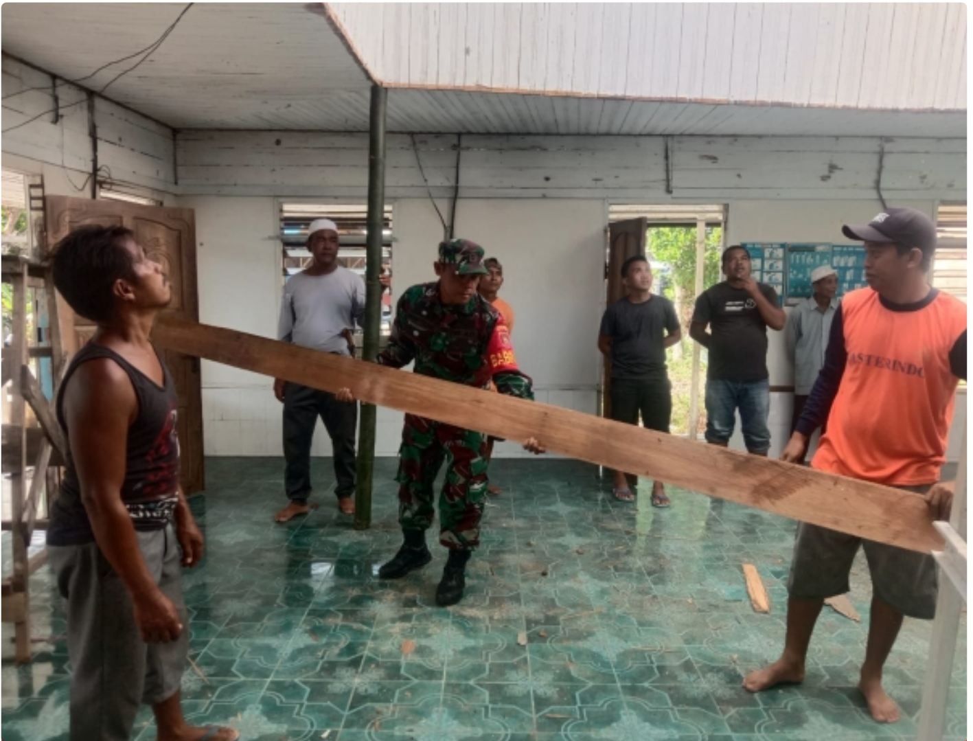
Sertu Irwan Berbaur Dengan Warga Binaan Bantu Renovasi Langgar Nurul Yaqin
