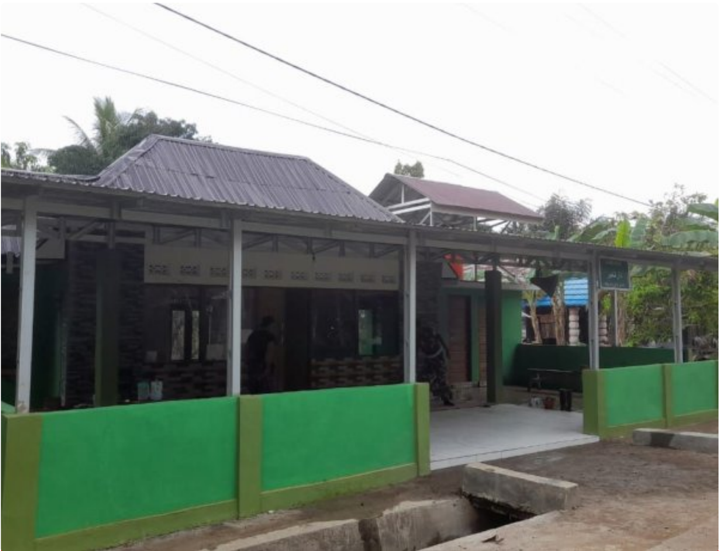
TMMD ke-116 Kodim HST Rampungkan Rehab Darul Khair
